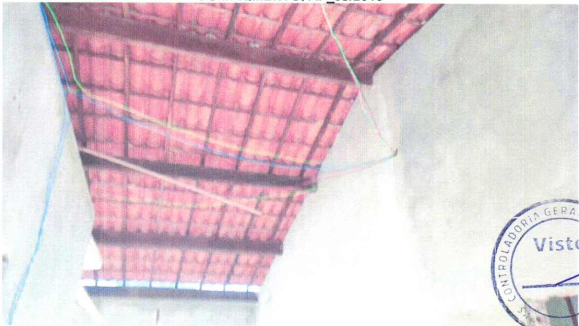
FOTO 04 - CABO DE COBRE FLEXÍVEL ISOLADO, 1,5 MM 2 , ANTI-CHAMA 450/750 V, PARA CIRCUITOS TERMINAIS - FORNECIMENTO E INSTALAÇÃO. AF_12/2015
