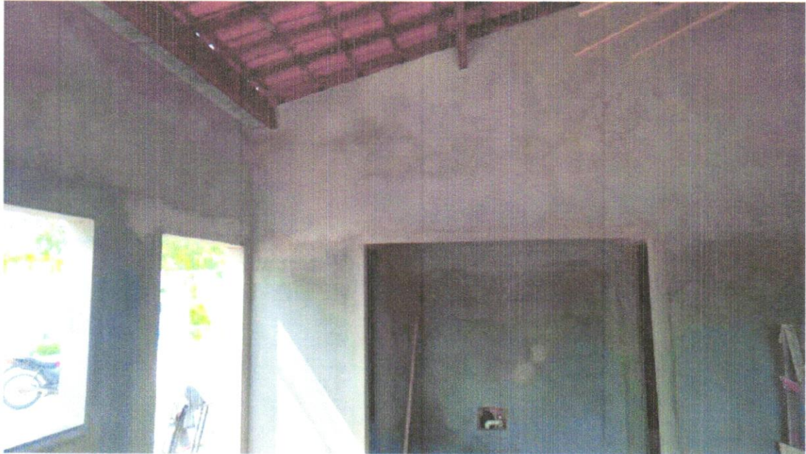
FOTO 03 - CONTRAVERGA PRÉ-MOLDADA PARA VÃOS DE ATÉ 1,5 M DE COMPRIMENTO. AF_03/2016
