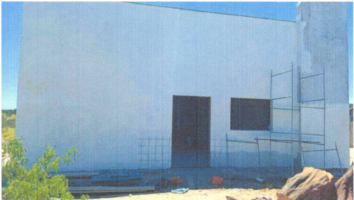
Foto 13 - APLICAÇÃO E LIXAMENTO DE MASSA LÁTEX EM PAREDES, UMA DEMÃO. AF_06/2014
